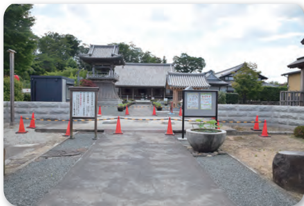
現在は、山門が解体撤去されています
