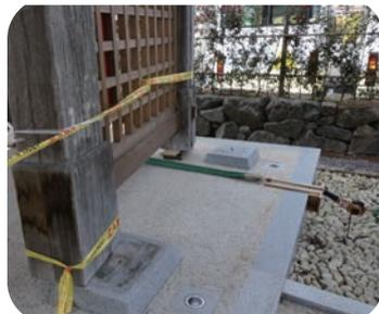
※臥牛門も地震により門自体がずれました。門自体に重大な損傷はなく、脚柱のずれを戻しました。
