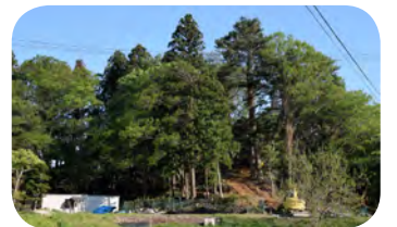
工事用道路施工中
